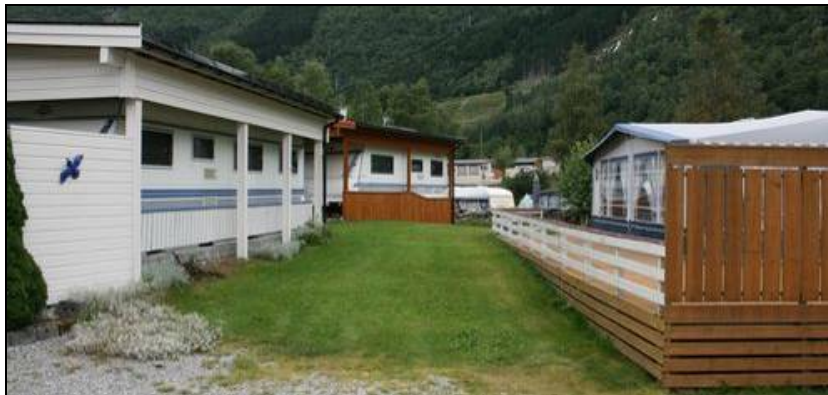
Innebygging (inkl. overbygging) av campingvogner gir faste konstruksjonar. Bilda over viser døme frå Jemtegård Feriesenter.
